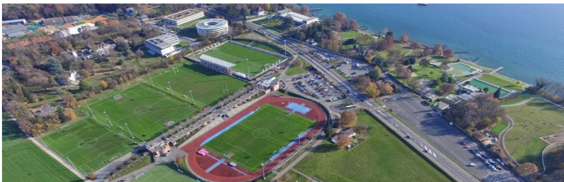
Vue générale du site de Colovray
