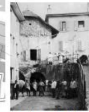
Les anciennes bassins de Nyon, en arrière-plan l'entrée du passage du Bas-Creux
