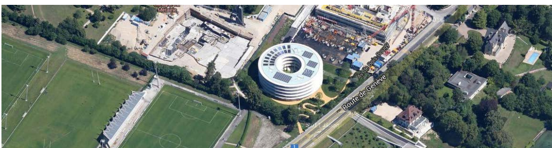
Bâtiments de l'UEFA végétation intensive sur parking souterrain et solaire thermique et photovoltaïque.
