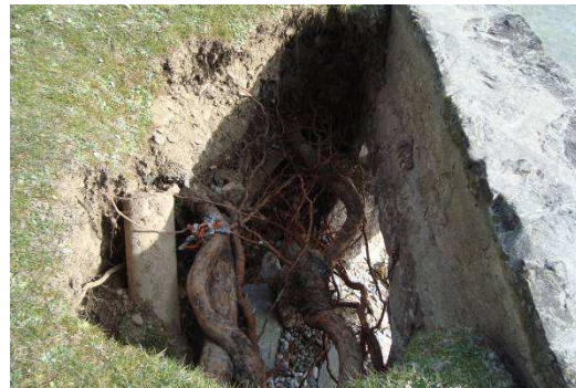
Trou dans le mur devant l'UEFA créé à cause du gel-dégel de février 2012 – état début mars 2012
