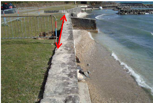
Trou dans le mur devant l'UEFA créé à cause du gel-dégel de février 2012 – état début mars 2012
