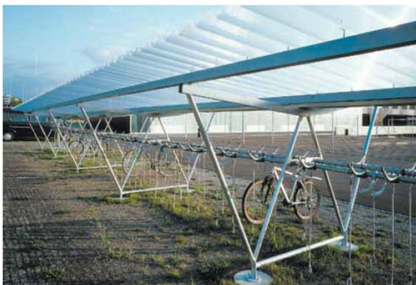
Parking abrité bilatéral pour d'immenses capacités, toiture translucide en polycarbonate.
