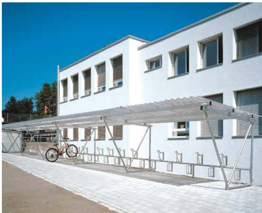
Abris unilatéral dans une école pendant les congés d'été, toiture translucide en polycarbonate.
