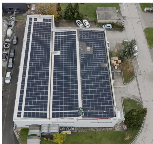
L'installation solaire sur le toit de NGL Cleaning Technology, société de haute technologie située à la Vuarpillière. Photo SI Nyon
