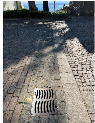
**Un clou et une grille d'écoulement – ou avaloir – d'eaux pluviales, à la place du Château.**
